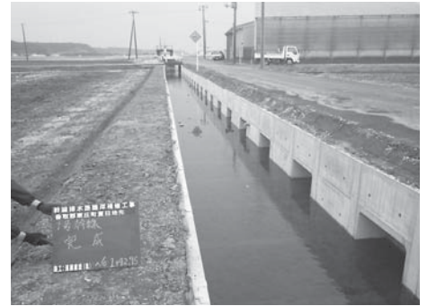
ストックマネジメント事業 夏目地区 (幹線排水路補修工事)
