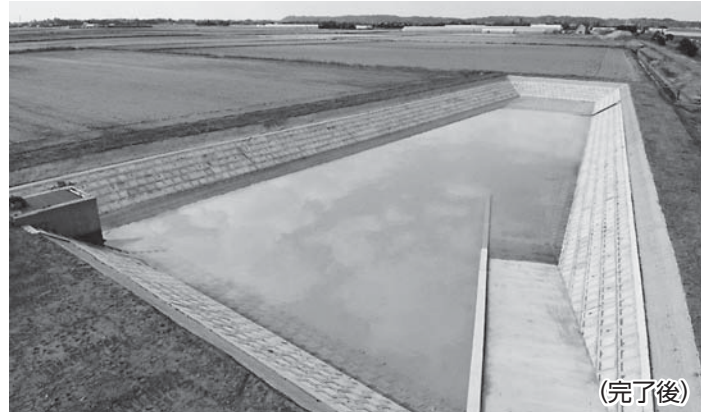
経営体育成基盤整備事業 春海地区 (第4 機場調整池護岸工事)
