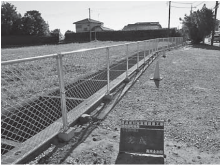
維持管理事業 (庄兵衛川安全柵設置工事)
