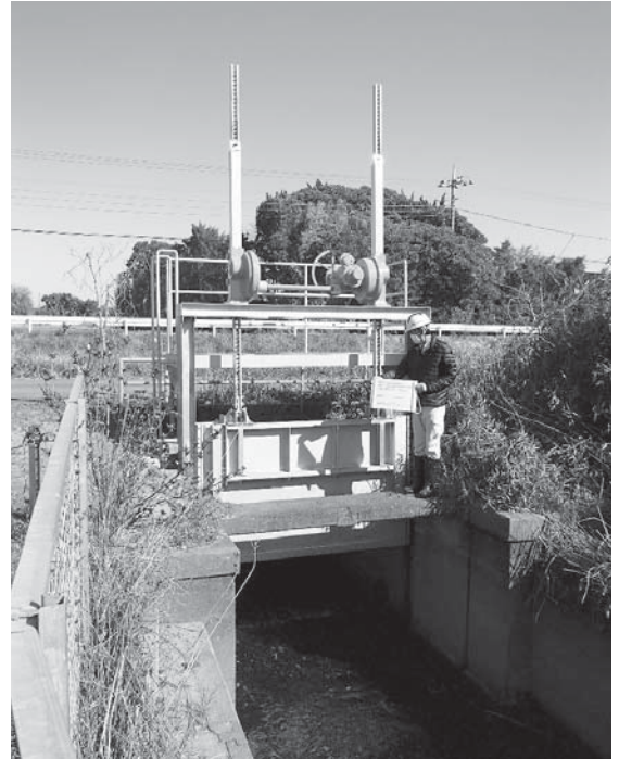
土地改良施設維持管理適正化事業 (神西川第1ゲート改修工事)
