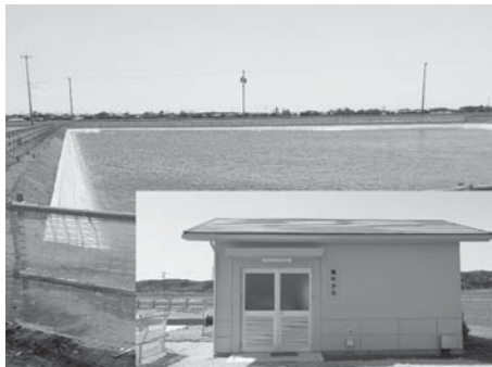
経営体育成基盤整備事業 (豊和第5 機場調整池護岸工事)
