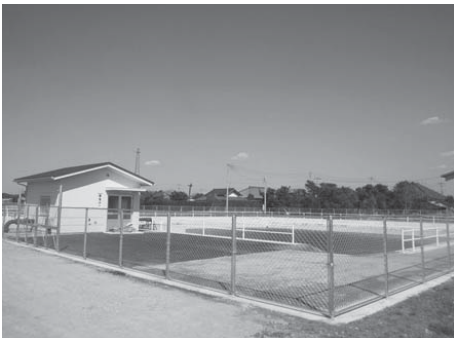
経営体育成基盤整備事業 (春海第1 機場場内整備工事)
