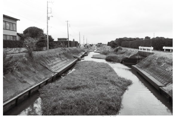
令和4年1月末までに秋田川の しゅんせつ 浚渫工事を完了させ、令和4年度に基幹水利施設ストックマネジメント事業採択に向けた県の審査会に諮り、令和6年度には全線約5,500mの大規模改修工事に着手の予定です
