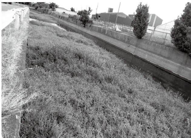
施工前の鐮木川
