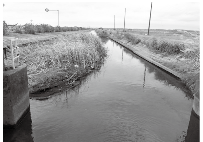
施工前の新七間川
