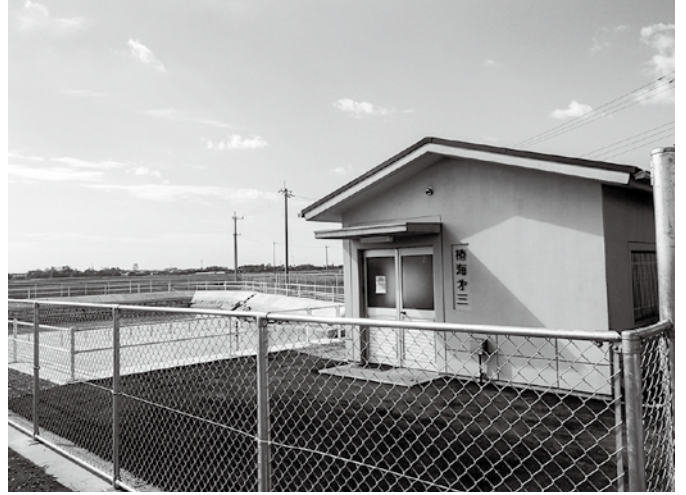
県営農地整備事業椿海支区 (椿海第3機場内整備工事)
