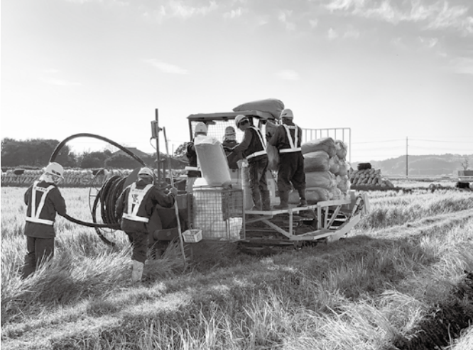
県営農地整備事業春海支区 (暗渠排水工事)
