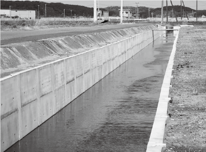
地域農業水利施設ストックマネジメント事業 (夏目地区幹線排水路補修工事)
