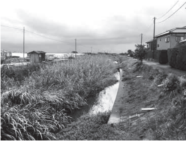
秋田川上流部 しゅんせつ 浚渫工事 (工事前)
