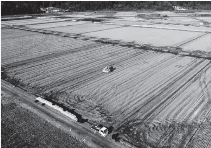
暗渠排水工事（豊和地区）
