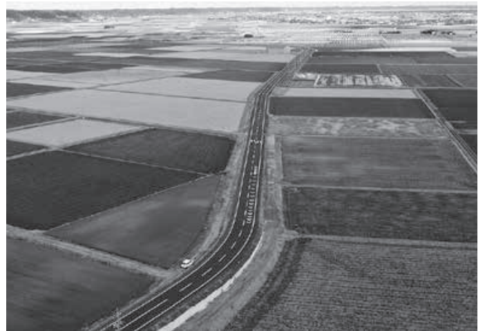
道路の全景（椿海地区）
