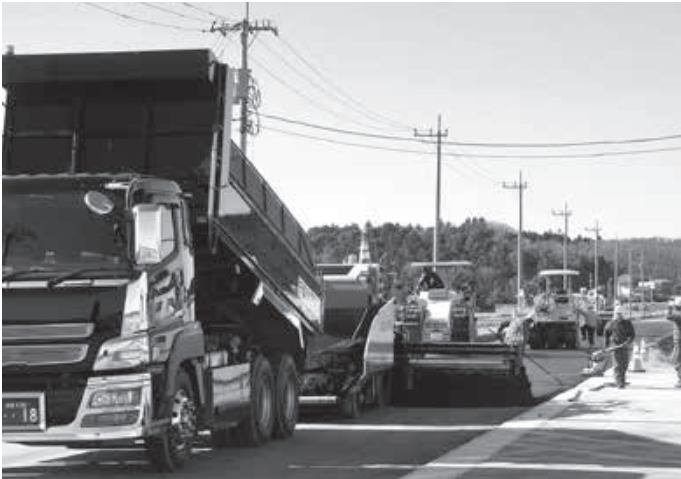
幹線道路舗装工事（椿海地区）
